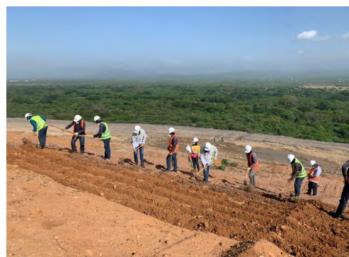
El proceso usa la técnica de realización de surcos con azadón y la siembra de semillas de pasto.
